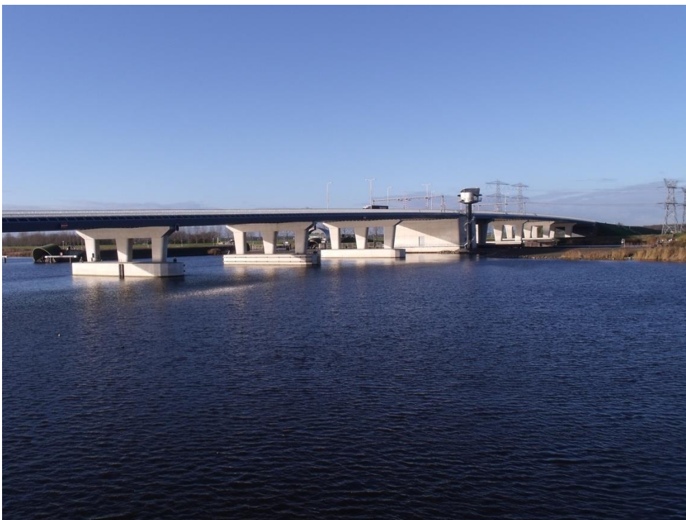
Nieuwe Rampolbrug gereed in 2012 Lengte brug 547 m. Doorvaarthoogte 13.6 m Doorvaartbreedte 18.2 m.
