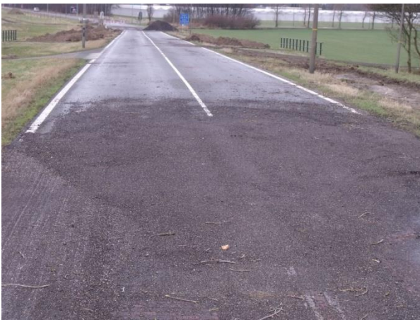
Bij het verwijderen van het asfalt kwam de eerste klinker bestrating in zicht, duidelijk te zien de witte middenstreep.
