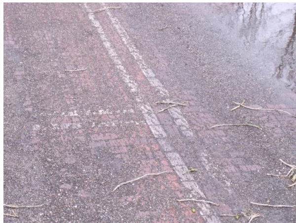
Bij het verwijderen van het asfalt kwam de eerste klinker bestrating in zicht, duidelijk te zien de witte middenstreep.
